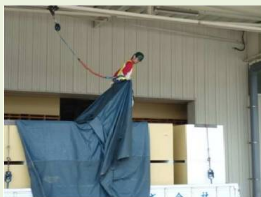
写真③ 安全帯取り付け設備
